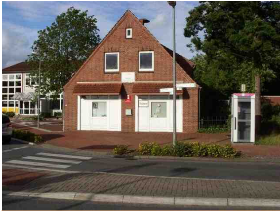
Anbau Infostube / Dienstleistungseinrichtung Fassaden- und Dacherneuerung erforderlich
