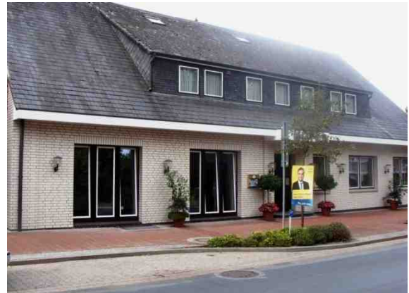
Hotel im Schwerpunkttraum - ortsbildverbessernde Dacherneuerung wünschenswert
